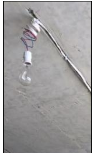
顶面灯线移位需用黄腊管包裹线路
