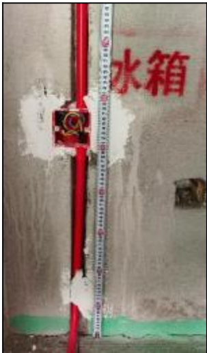
普通冰箱插座： 350 超薄镶嵌式：按设备尺寸
