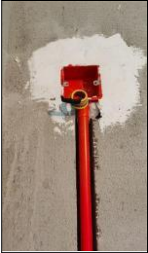
定制柜体预留电源高度：距地2米
