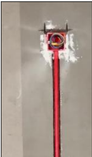
吊柜底部照明（灯带）：距地2米2
