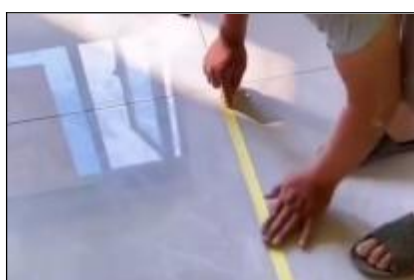
纸胶带保护瓷砖缝隙
