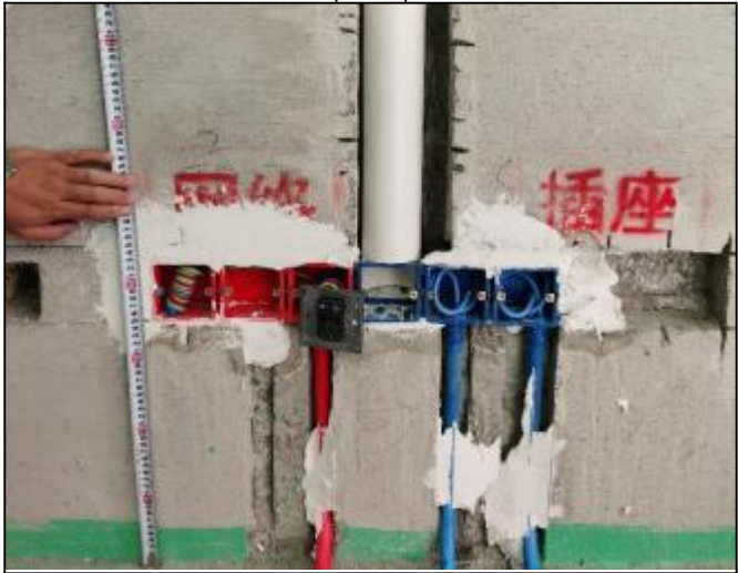
电视墙居中左侧预留3-4个插座，右侧网线光纤高度：距地350
