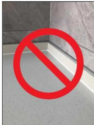
厨房台面和墙面收口
