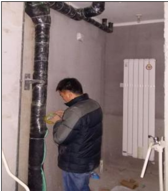
外露下水管道隔音棉包裹
