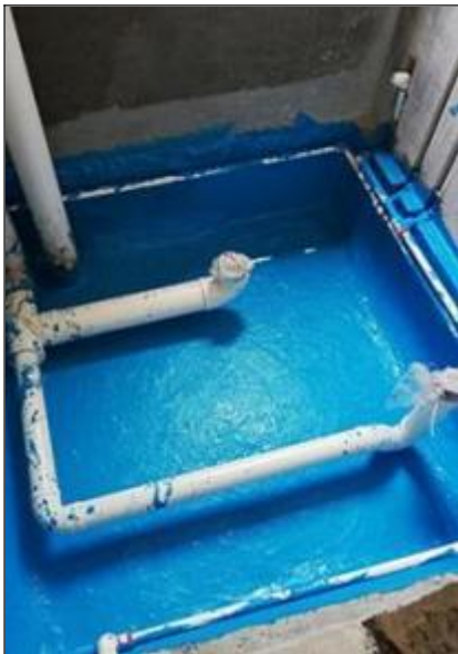
卫 生 间 区 域 防 水
