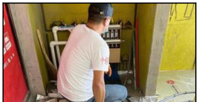
▲⑥系统打压检验
