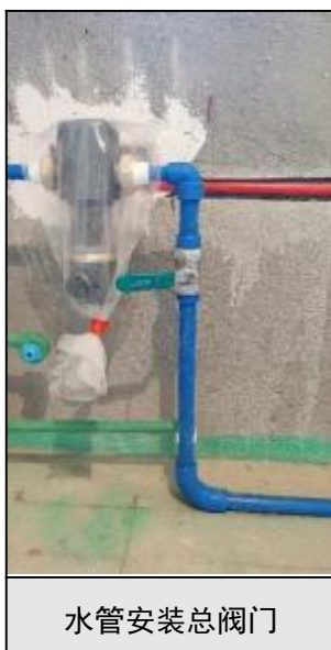
水路、电路，禁止同槽 走管，必须分管分槽
