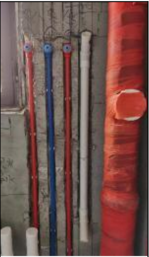
燃气热水器预埋直径50PVC管道
