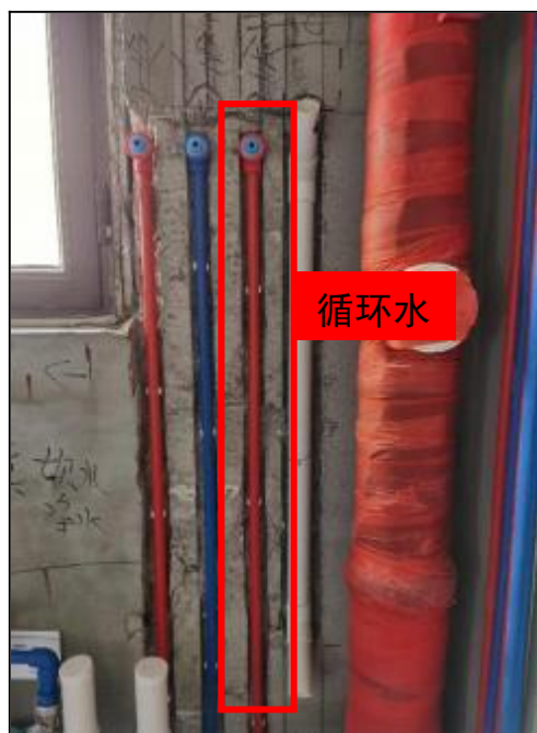
壁挂炉处按要求留循环水
